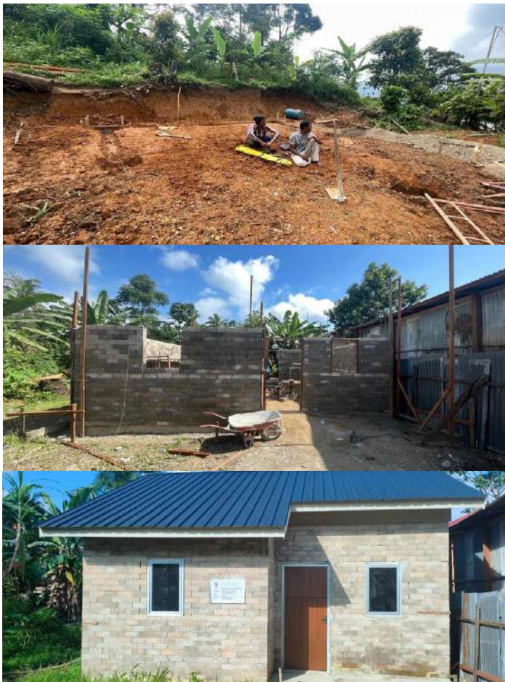
Gambar 3.49 Pembangunan Rumah Layak Huni Kondisi 0%, 50% dan 100%
