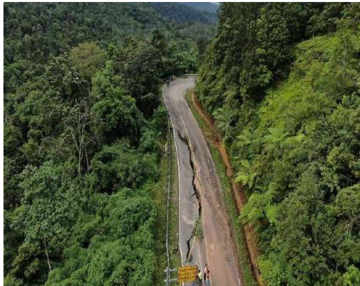
Gambar 3.56 Jalan Lintas Sumbar-Riau yang rusak akibat longsor di Kabupaten Lima Puluh Kota.
